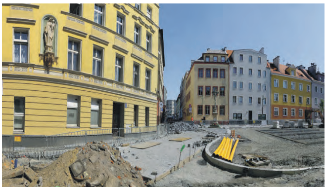
Przebudowa placu, fot. Jerzy Stemplewski
